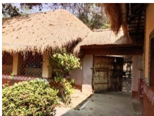
Entrée du pavillon Gandhi
