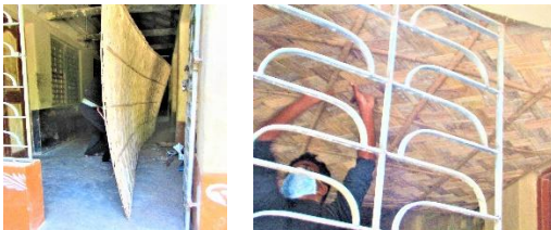
False ceiling in dormat.
